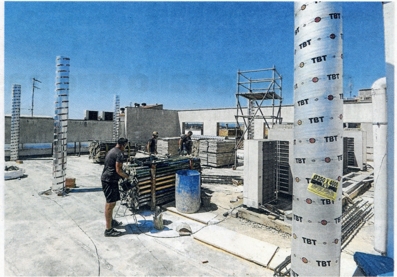
Ja han començat les obres de reforma de la biblioteca. FOTO: JOAN REVILLAS
