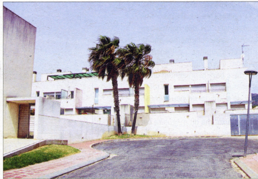
Imatge del bloc d’habitatges construït amb la llicència il·legal per la promotora Turov a Alcanar Platja, que han de ser enderrocats. / ACN
