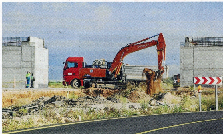
Obres en execució a la carretera N-238. FOTO: JOAN REVILLAS
