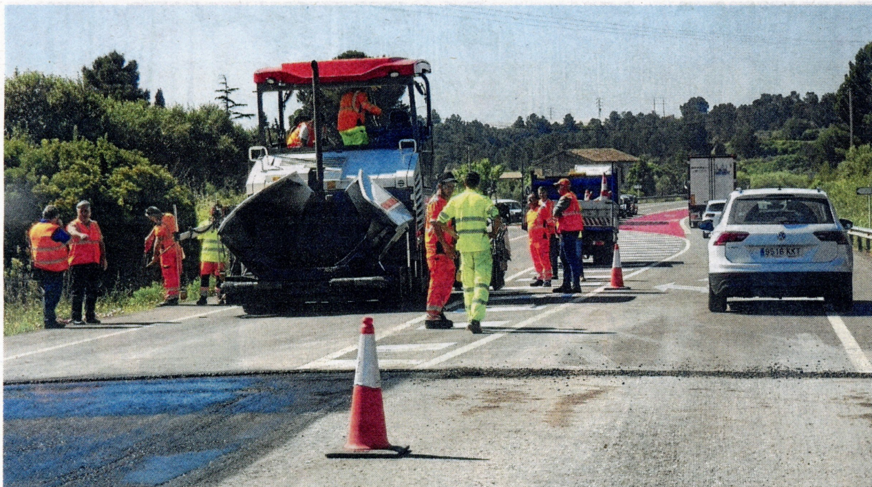
Treballs de renovació del ferm, a la carretera C-12. FOTO: JOAN REVILLAS
