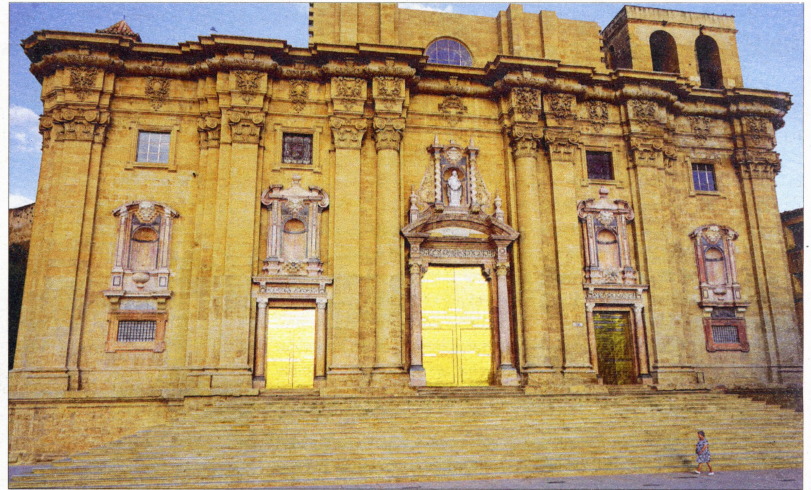
La neteja i rehabilitació de la façana permeten recuperar-ne tot l'esplendor arquitectònic, però també descobrir clarament que l'obra es va aturar de sobte sense ni tan sols una senzilla cornisa per a rematar la construcció. FOTO NÚRIA CARO
