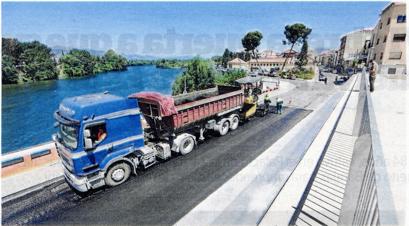
Treballs d'asfaltatge, en marxa, a l'avinguda Felip Pedrell. FOTO: JOAN REVILLAS
