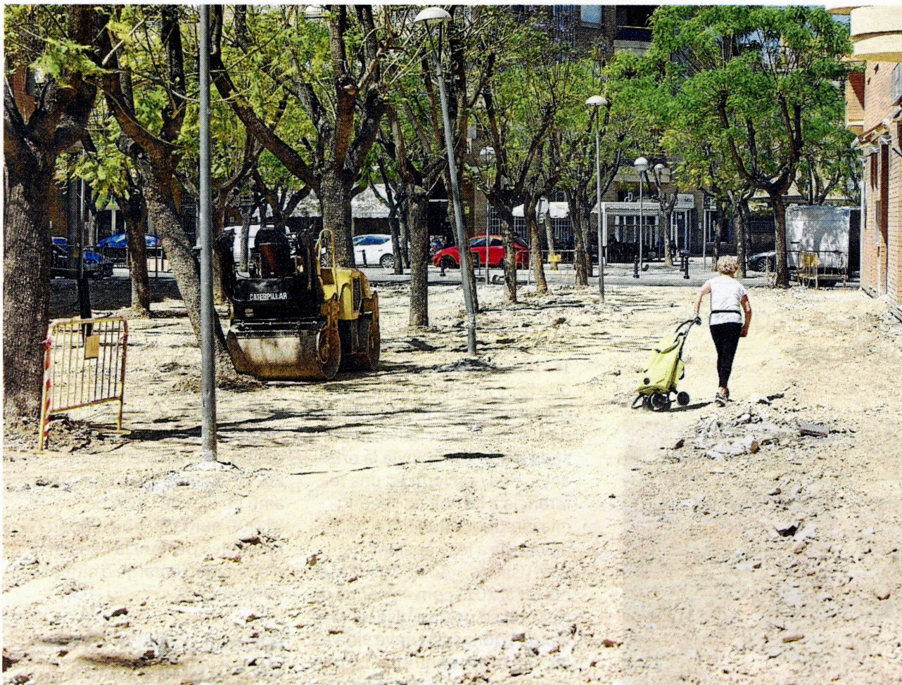
El carrer que actualment està en obres, al barri del Temple. FOTO: JOAN REVILLAS
