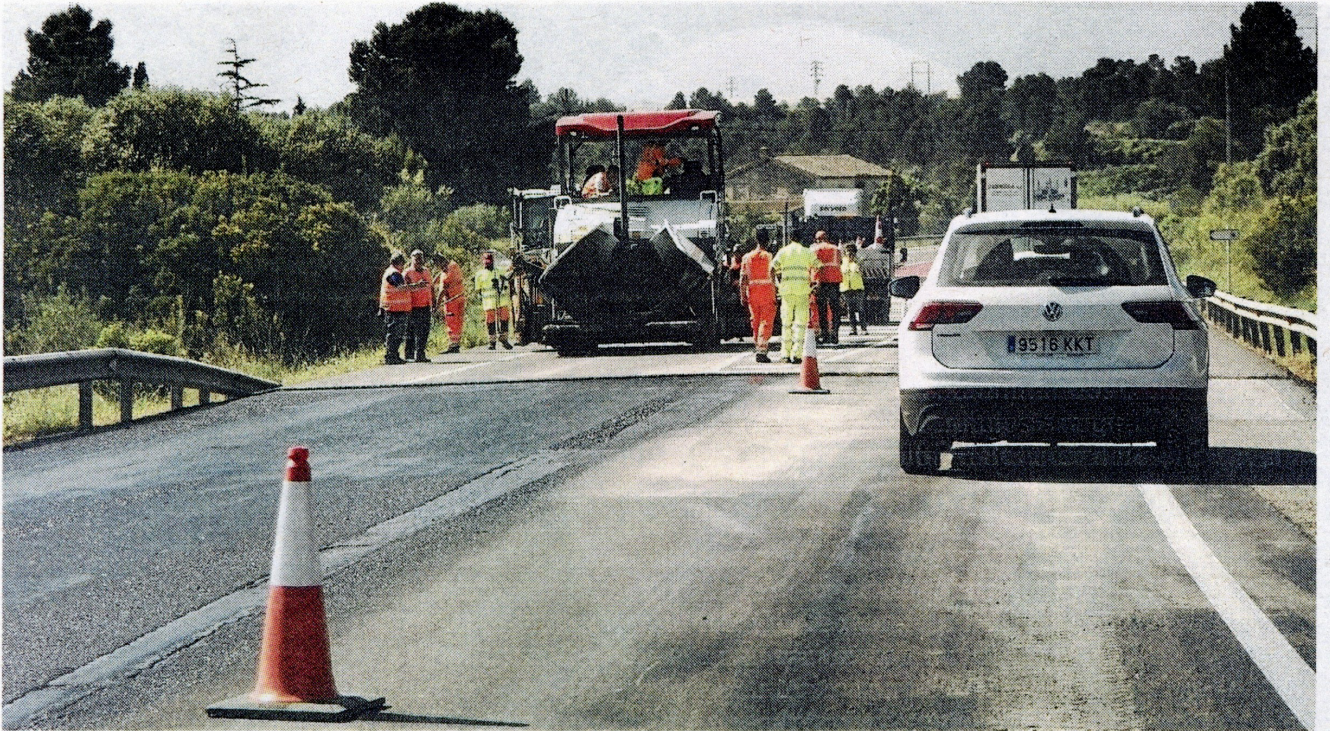
Reforma del ferm en marxa a la C-12, entre Xerta i Benifallet. FOTO: JOAN REVILLAS
