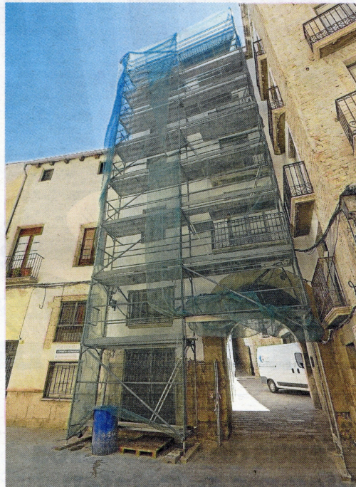
Restauració d'una façana al carrer Croera, al nucli antic de Tortosa.
