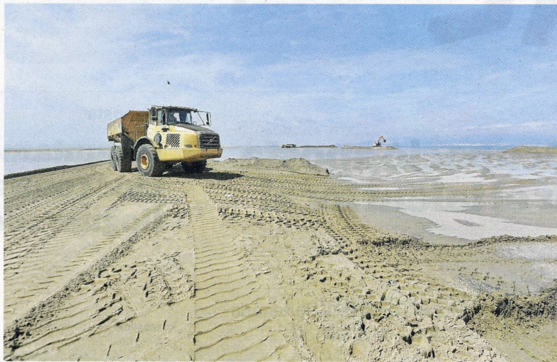
Treballs de reposició d'arenes a la barra del Trabucador. FOTO: JOAN REVILLAS
