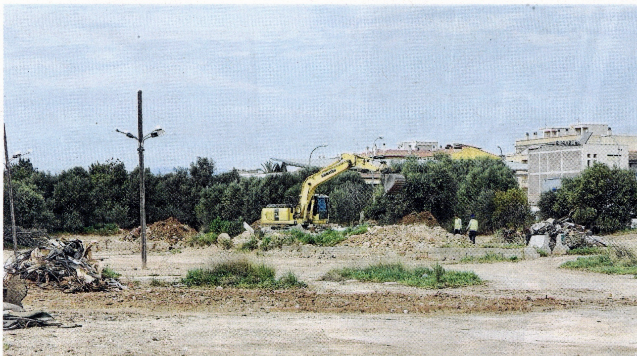
Treballs de gestió de la runa, als terrenys de la plaça de bous. FOTO: JOAN REVILLAS
