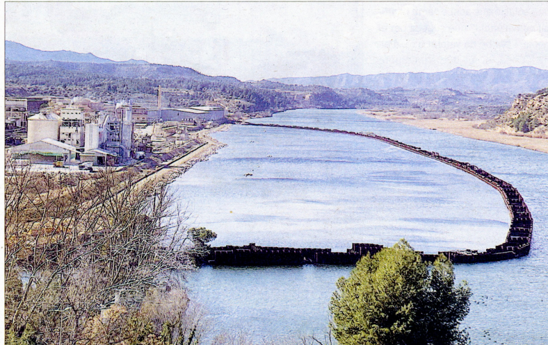
Imatge del tancat de palplanxat que encara hi ha a l'embassament de Flix.
