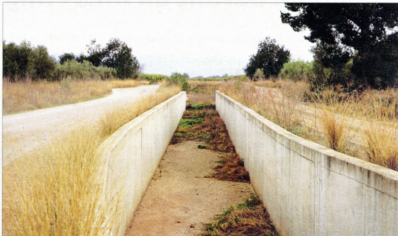
El projecte del canal ha anat reculant d'ençà que es va projectar fa mig segle. Tenia una llargada prevista de 215 km i sembla que es quedarà en poc més de 22.
