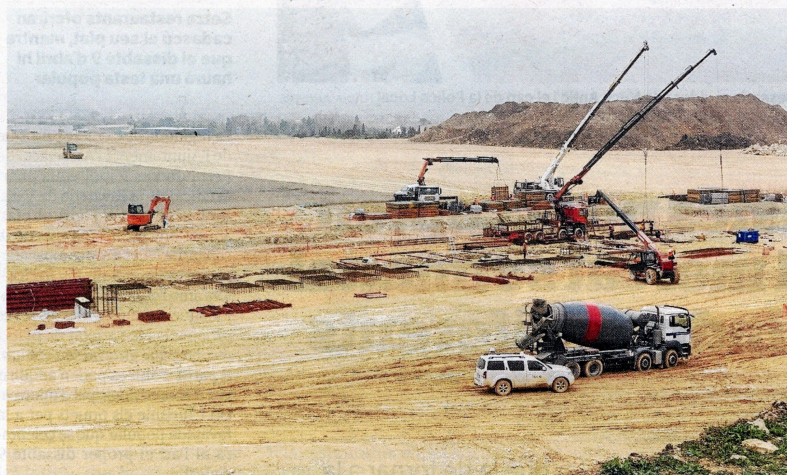
Obres de Kronospan al polígon Catalunya Sud. FOTO: JOAN REVILLAS
