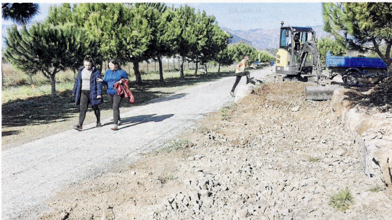
Obres a la Via Verda, entre Tortosa i Roquetes. FOTO: JOAN REVILLAS
