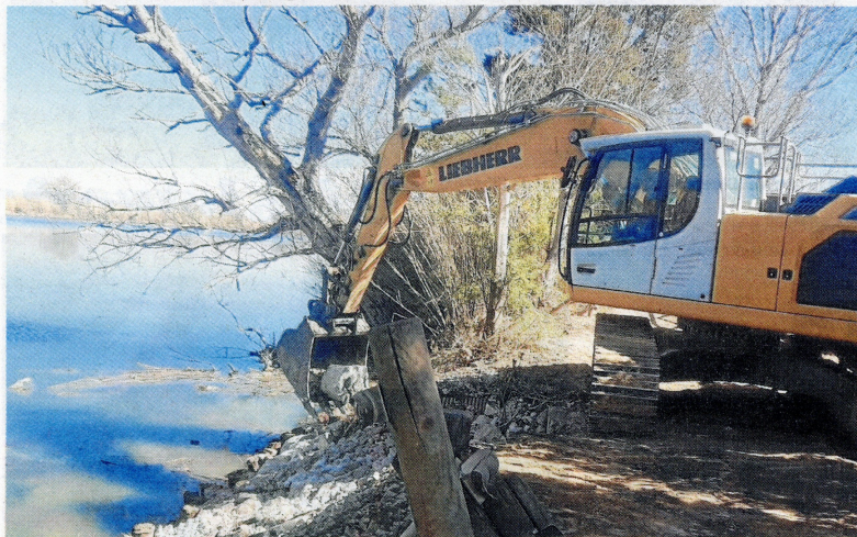
Treballs de reforç dels talussos, al marge dret del riu Ebre. FOTO: CEDIDA
