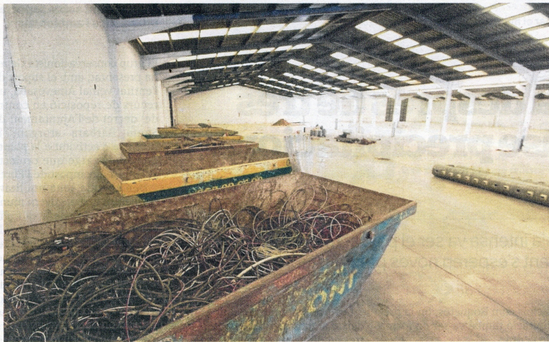
Obres d'enderroc a l'interior del pavelló firal d'Amposta. FOTO: JOAN REVILLAS
