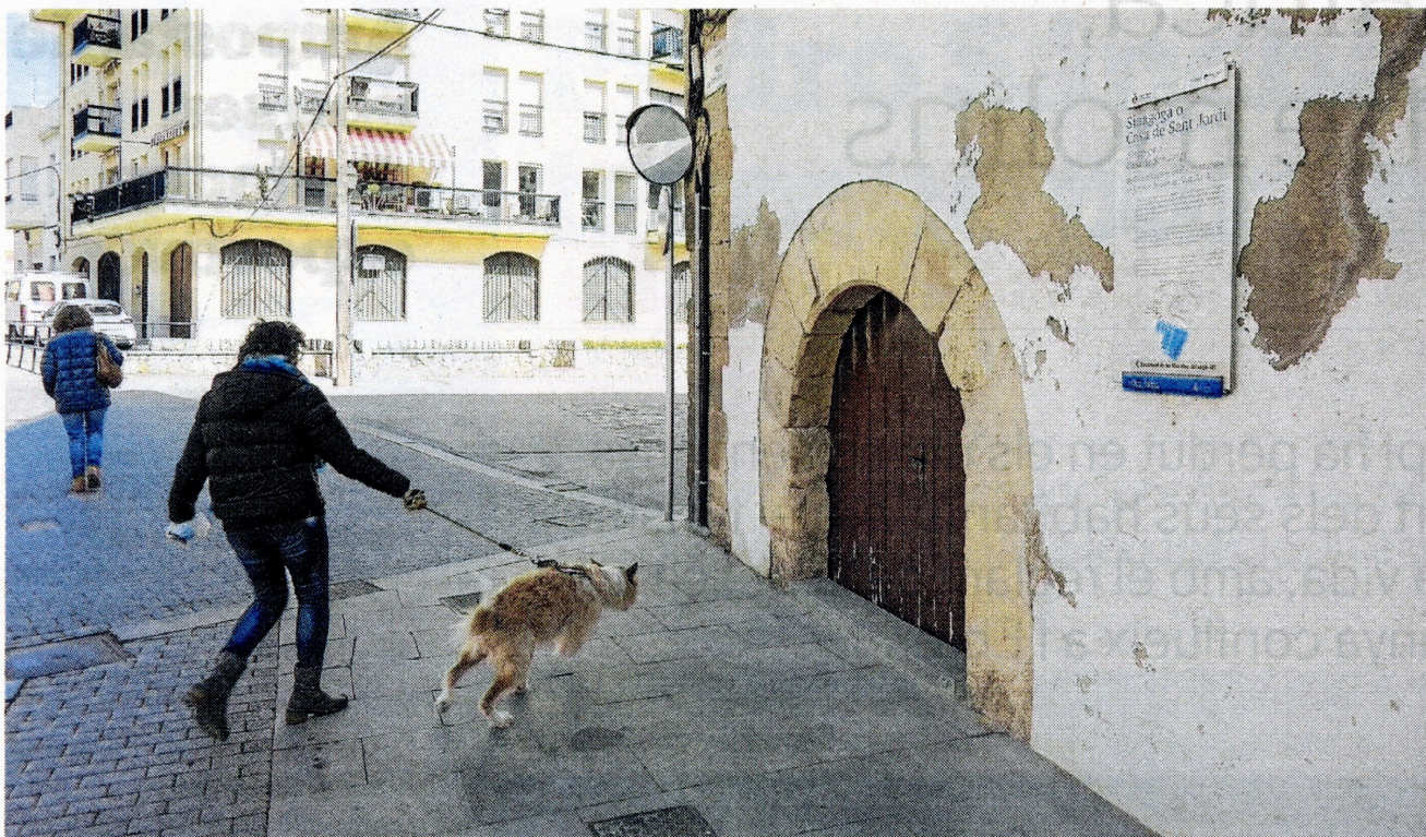
La sinagoga o Casa de Sant Jordi, al carrer Major de Remolins. FOTO: JOAN REVILLAS
