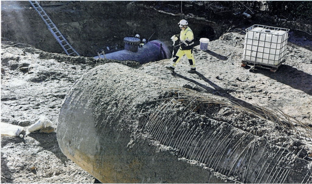
Operaris reparant la canonada d'aigua afectada pel trencament a l'Ametlla de Mar, el desembre passat. FOTO: JOAN REVILLAS
