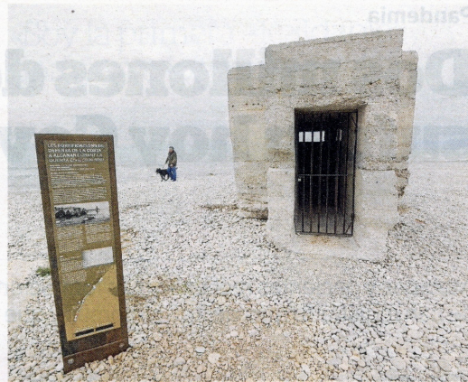
Detall dels plafons i les portes instal·lades. FOTO: JOAN REVILLAS
