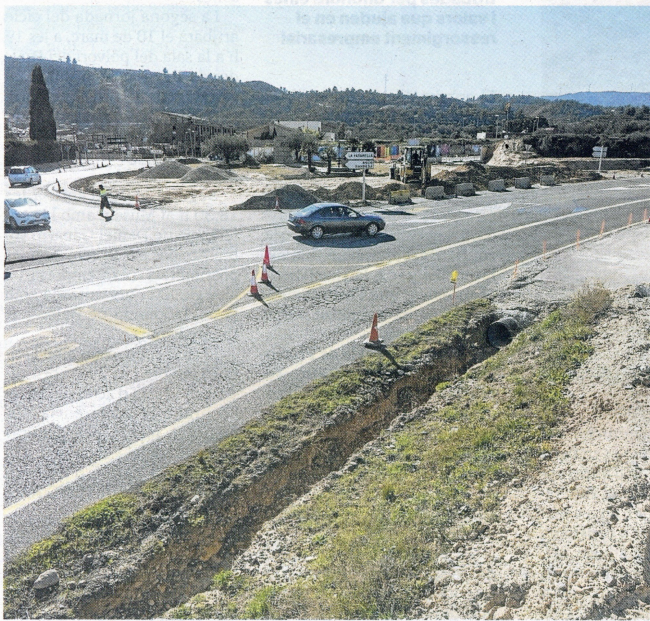
Obres de la rotonda a Ascó. FOTO: JOAN REVILLAS
