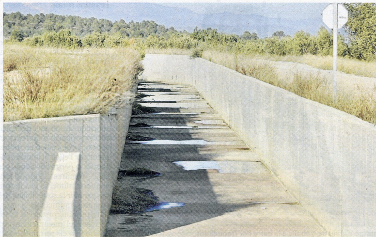
Detall de la infraestructura ja creada del canal. FOTO: JOAN REVILLAS
