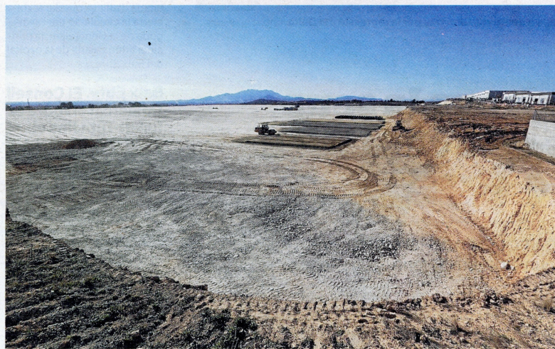
Moviments de terres de l'empresa Kronospan al Catalunya Sud. FOTO: JOAN REVILLAS
