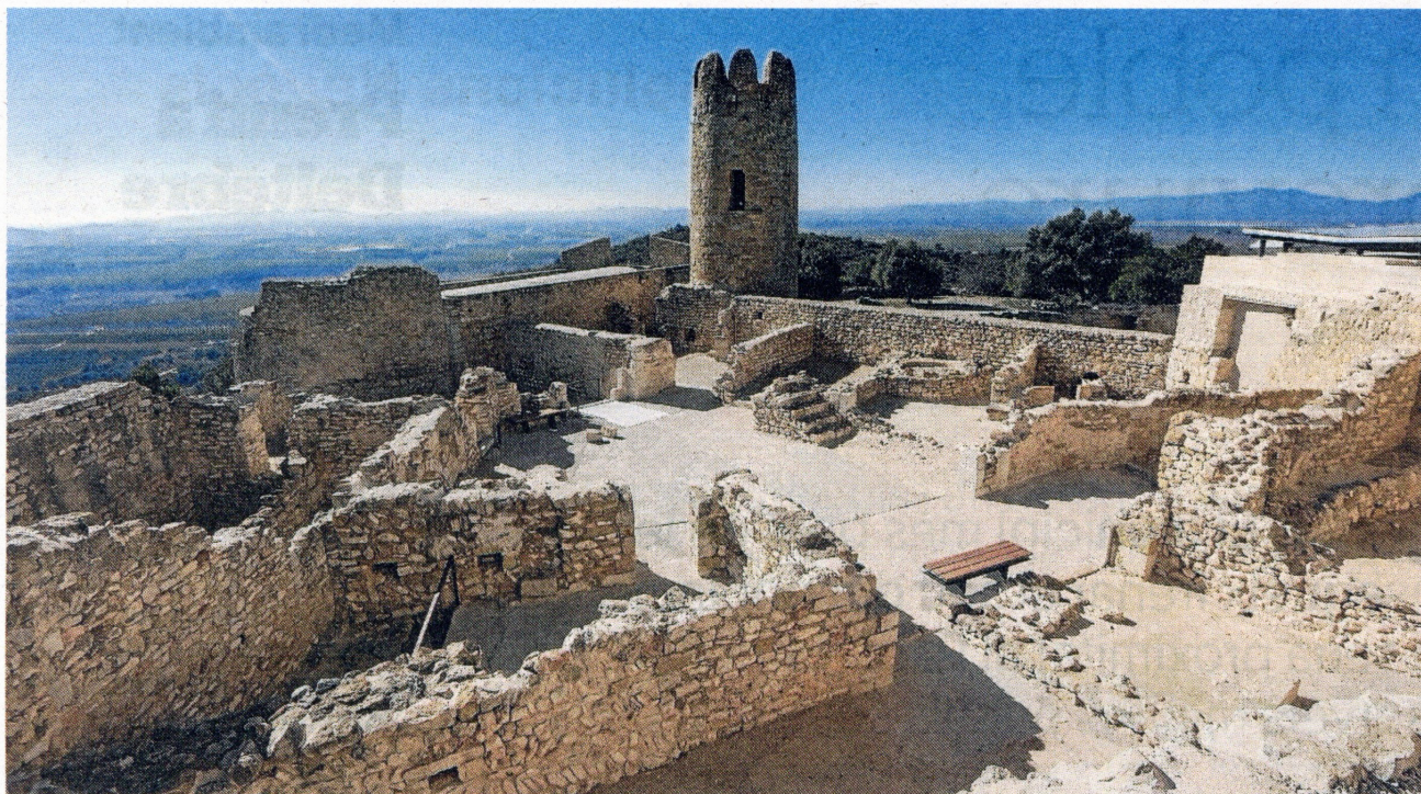
Durant les obres s'ha restaurat elements patrimonials danyats pel pas del temps. FOTO: JOAN REVILLAS
