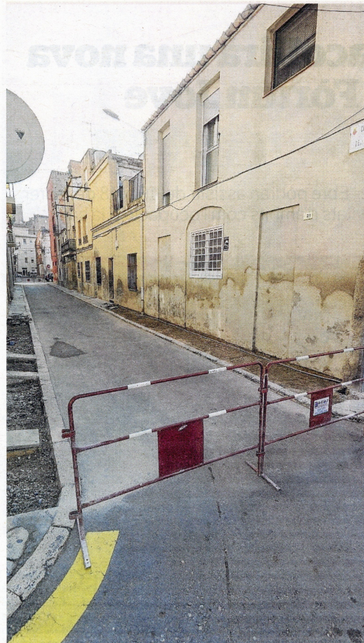
Ahir dilluns van començar les obres als carrers Pina i Amor de Ferreries. FOTO: JOAN REVILLAS
