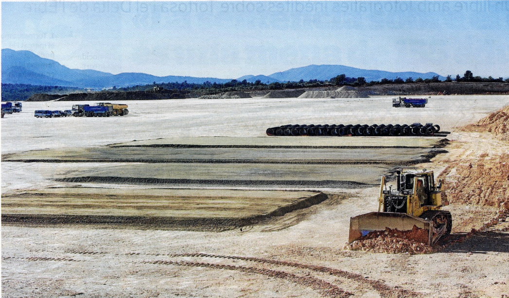
Estat actual de les obres de la gran fàbrica de Kronospan, al polígon Catalunya Sud. FOTO: JOAN REVILLAS
