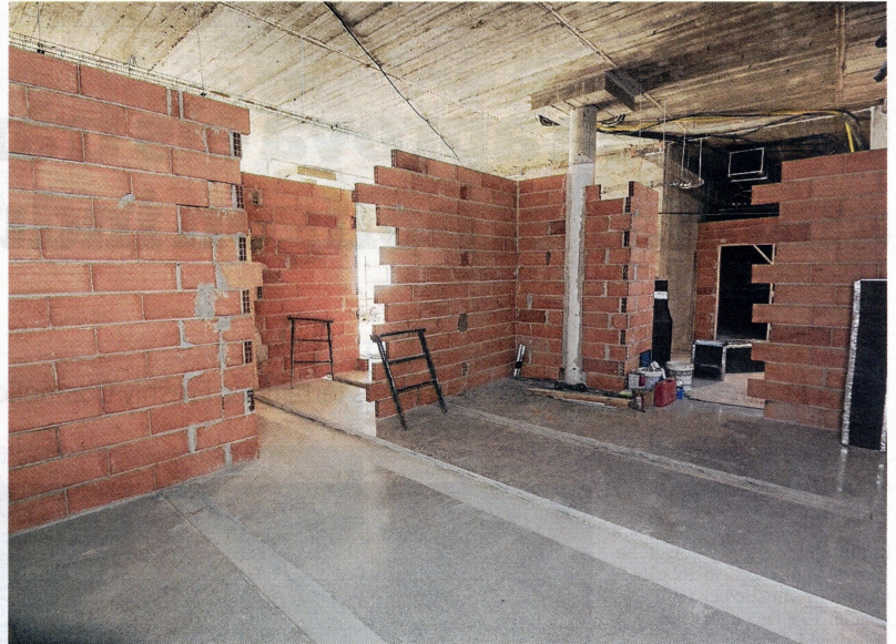
Obres en marxa a l'Hospital Comarcal de Móra d'Ebre.
