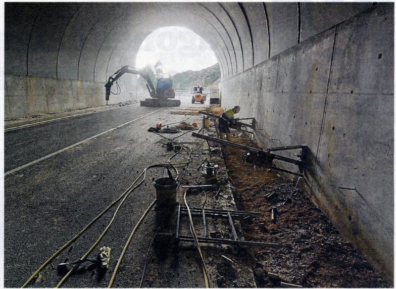
Treballs en marxa al túnel de la carretera d'Horta.
