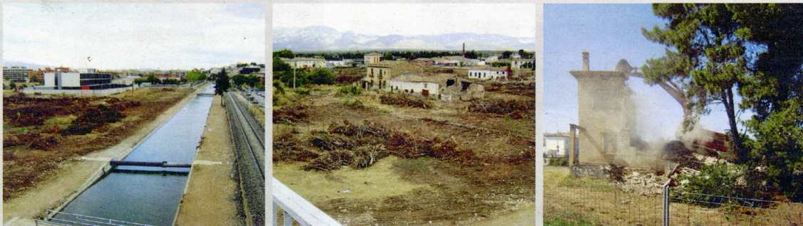
Desbrossament i demolició de les edificacions existents. Fotos: SB Immobiliària.
