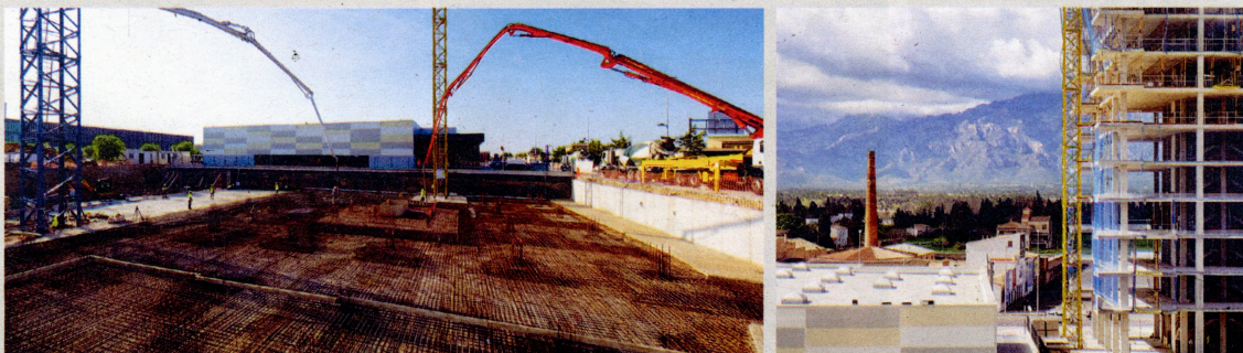
Inici de les obres del Residencial SB Porta Tortosa: muntatge de grues i fonaments. Fotos: SB Immobiliària.
