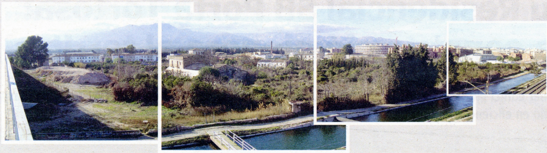
Estat inicial del sector abans d'iniciar les obres. Foto: SB Immobiliària.
