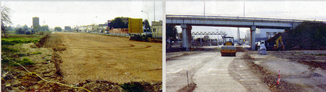
Construcció dels carrers i voreres. Vistes de la transformació i ampliació de l'Avinguda Generalitat. Fotos: SB Immobiliària.
