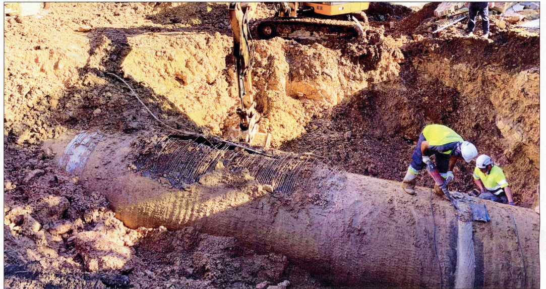
Treballs de reparació de la canonada principal de formigó, que es va trencar a l'Ametlla de Mar. / CAT
