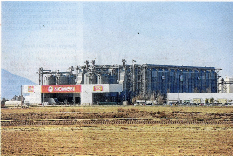
Les instal·lacions de Nomen Foods, de la Cooperativa Arrossaires del Delta. FOTO: JOAN REVILLAS
