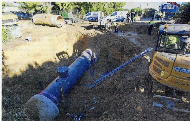
Treballs de reparació en el tram afectat pel col·lapse a l'altura de l'Ametlla de Mar. FOTO: JOAN REVILLAS
