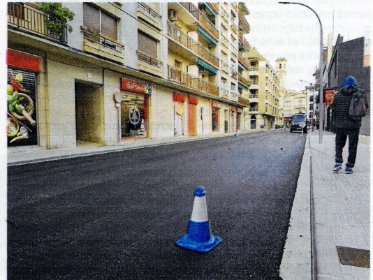
Nou asfaltatge al carrer Alcanyís. FOTO: JOAN REVILLAS
