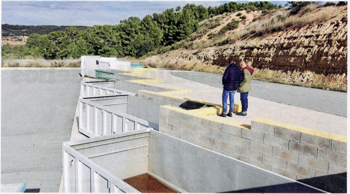
Les noves instal·lacions inaugurades a Gandesa. FOTO: JOAN REVILLAS
