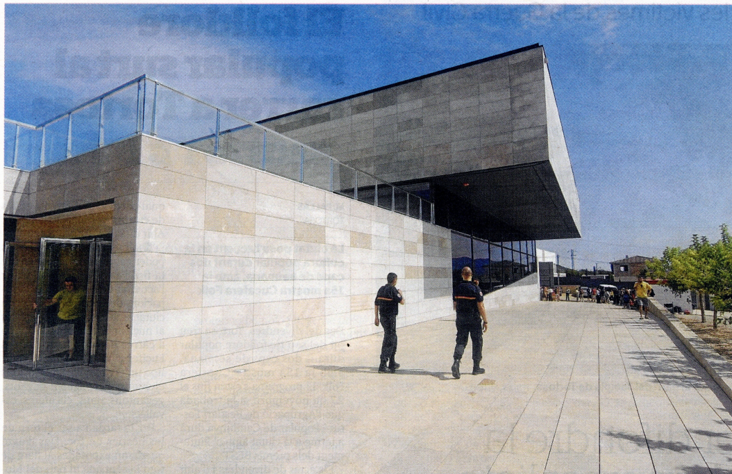
Ulldecona està treballant en un projecte per instal·lar plaques fotovoltaïques al seu pavelló esportiu. FOTO: JOAN REVILLAS
