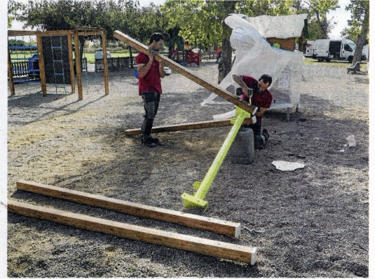
Instal·lant els nous jocs, ahir al matí. FOTO: JOAN REVILLAS
