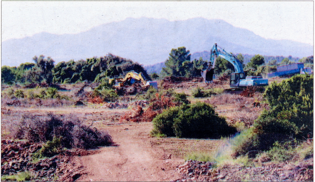
Primers moviments de terres als terrenys del Catalunya Sud, que ocuparà la nova planta de l'empresa Kronospan. / ACN
