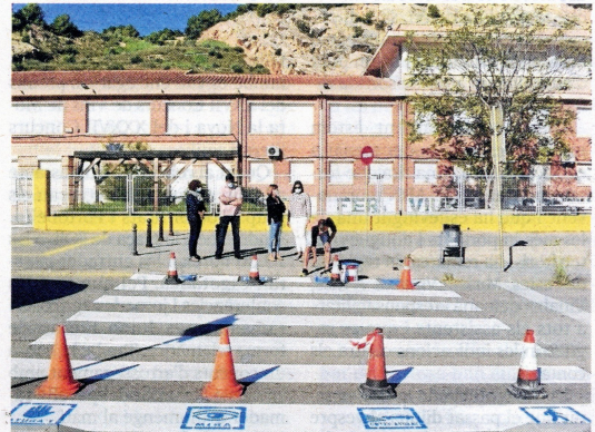
Detall de les pintades als passos de vianants. FOTO: AJUNTAMENT DE LA RÀPITA
