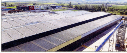
Imatge de la planta que Kronospan té a Burgos, amb panells solars als sostres. Una delegació de l'Ajuntament la va visitar al juny. FOTO: CEDIDA
