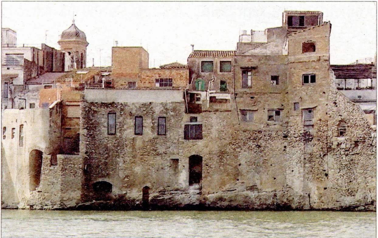
Imatge d'arxiu de la façana fluvial d'Amposta. / CANAL TE
