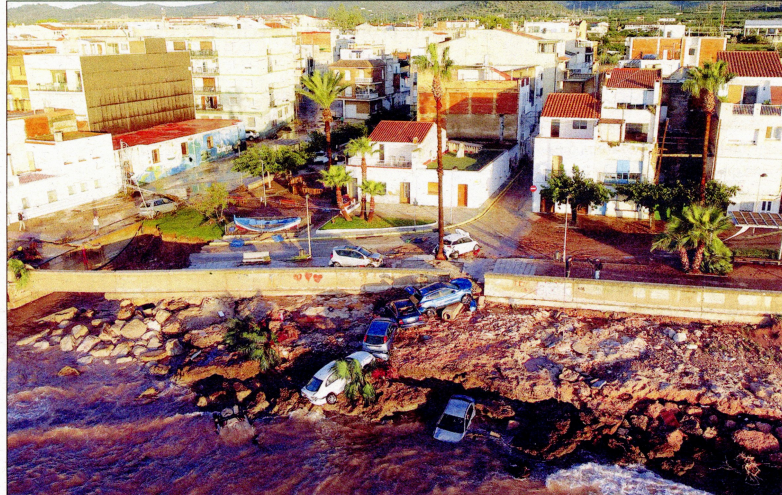
Imatge dels últims aiguats a la costa d'Alcanar, on s'aprecia la desembocadura d'un barranc integrat a la trama urbana. JOSEP ROLLAN
