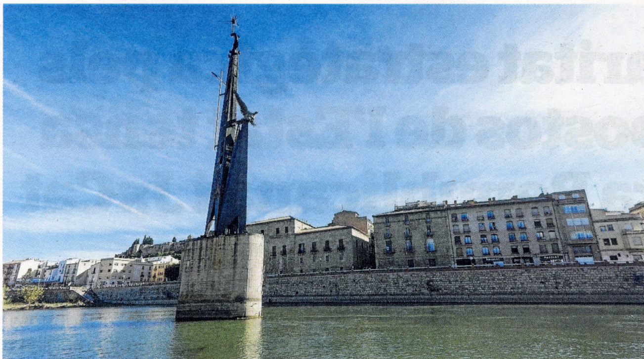
Amb la modificació del planejament municipal, es podrà construir una passarel·la. FOTO: JOAN REVILLAS
