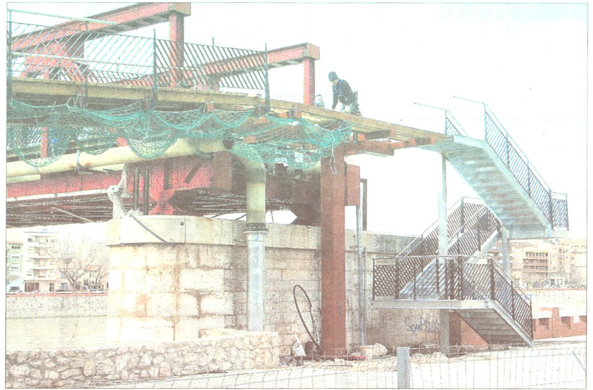
Estat actual de les obres d'adequació del pont i els seus accessos. FOTO: JOAN REVILLAS
