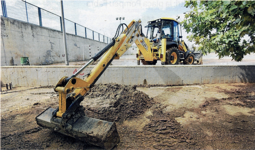
Màquines treballant ahir al matí a l'Institut Sòl de Riu d'Alcanar, afectat pels aiguats, per deixar el pati a punt per dilluns. FOTO: JOAN REVILLAS
