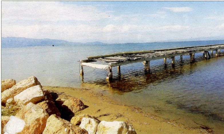
L'antic moll de fusta de les Salines actualment desballestat.
