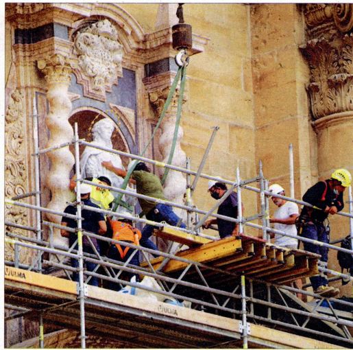
Detall de la instal·lació de l'estàtua, a la façana central. FOTO NÚRIA CARO
