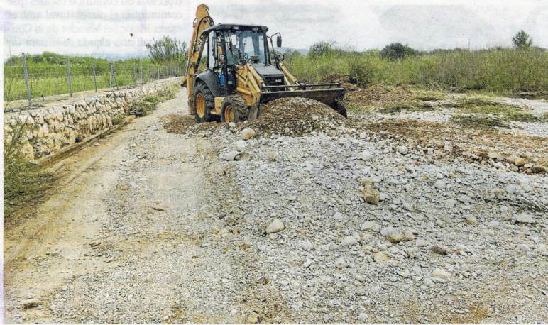
Una màquina retirant pedres del camí dels Valentins, ahir. FOTO: JOAN REVILLAS
