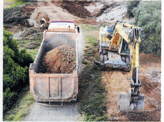
Treballs de reparació provisional de camins, en marxa. FOTO: CEDIDA
