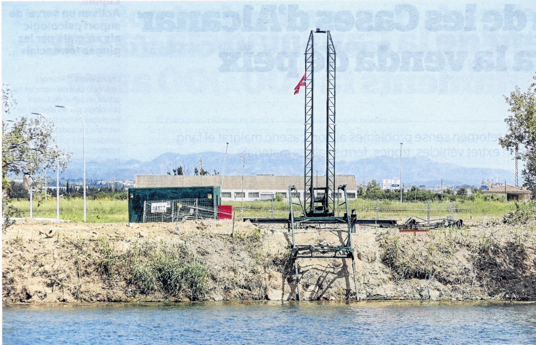
La marina seca s'està construint entre els terrenys de l'empresa Saica Pack i el pont penjant. FOTO: JOAN REVILLAS
