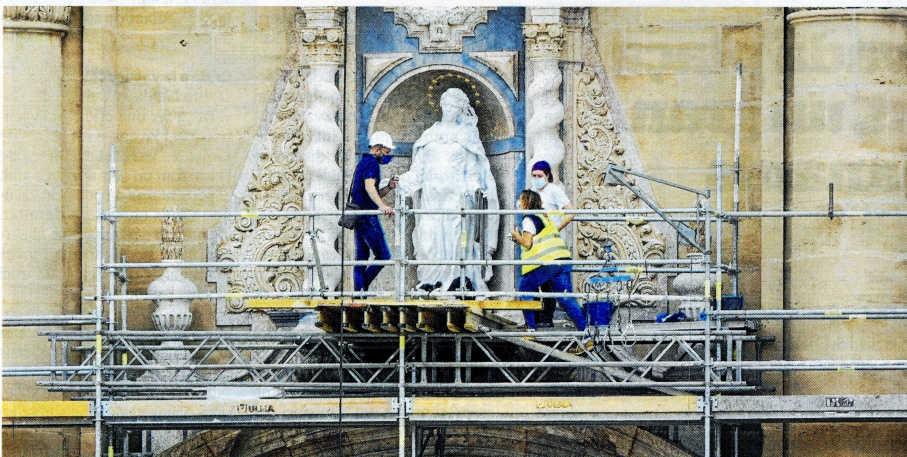
Els treballs d'instal·lació de la imatge van ser portats a terme amb una gran grua i una bastida. FOTO: JOAN REVILLAS
